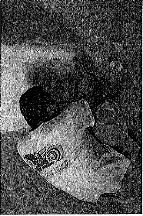
Foto 12. Aplicación de inyección en muro con estuco, Edificio 218, Yaxha
